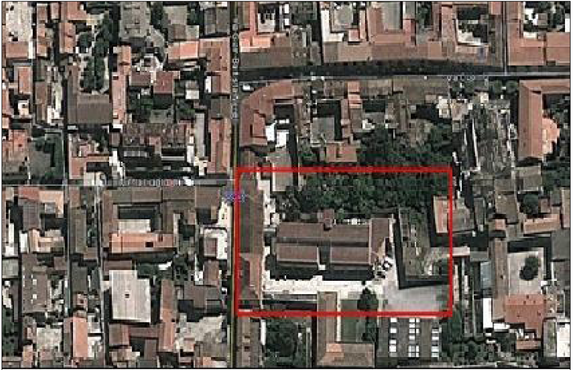
Edificio scolastico oggetto d'intervento
